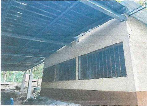
Foto 1: *Instalación de balcones en aula de preprimaria.*
